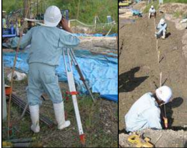
探査孔位置出し状況
