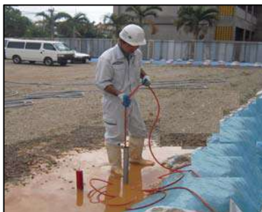
鉛直探査状況
