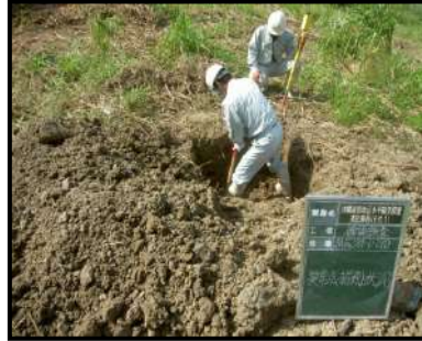
確認掘削状況
