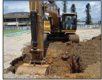
重機併用による掘削状況
