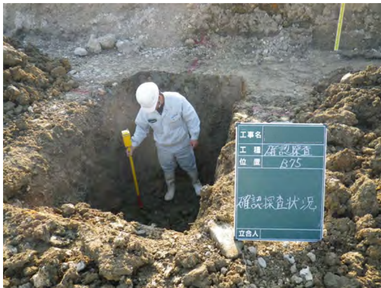
簡易探知機を用いた磁気異常点の確認
