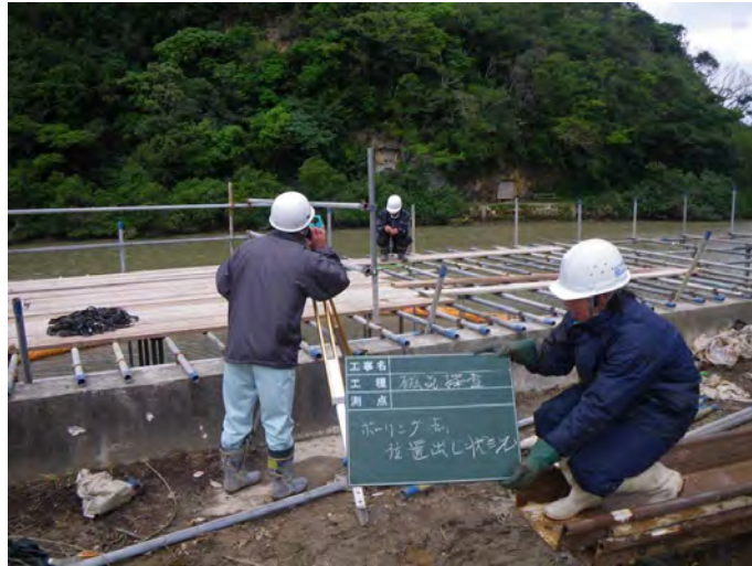
測量状況（鉛直探査）
