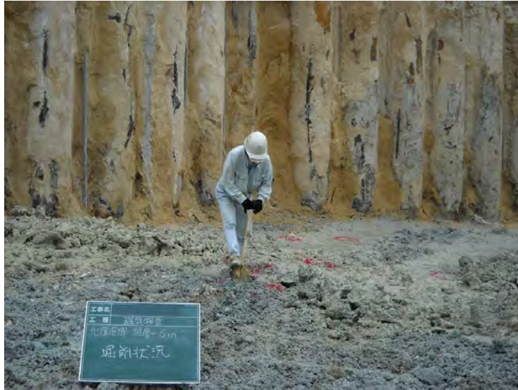
異常点の人力掘削状況
