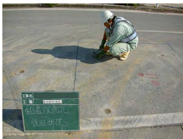
探査孔の埋戻し
