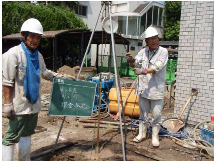
鉛直探査状況
