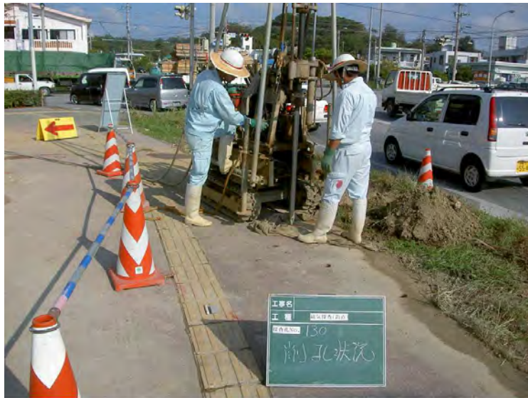
ボーリングマシンによる掘進状況
