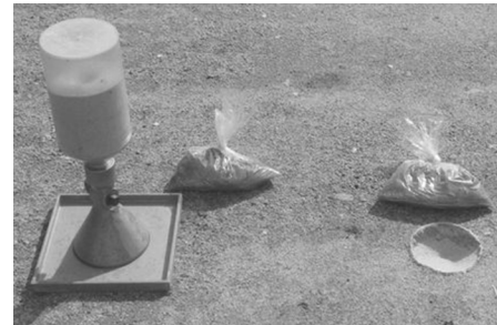
現場密度試験
