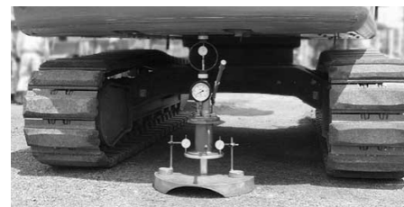
現場CBR試験
