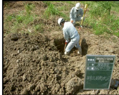
確認掘削状況
