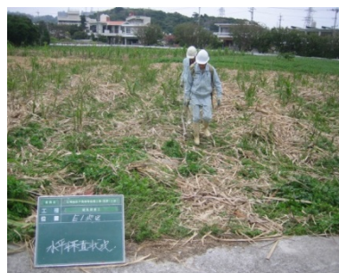
水平探査状況
