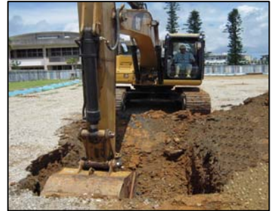
重機併用による掘削状況
