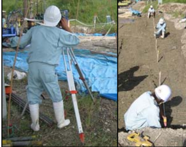
探査孔位置出し状況
