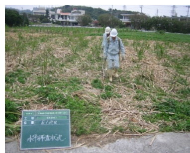
水平探査状況
