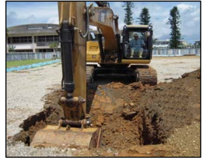
重機併用による掘削状況
