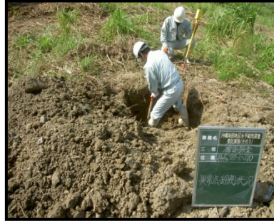
確認掘削状況
